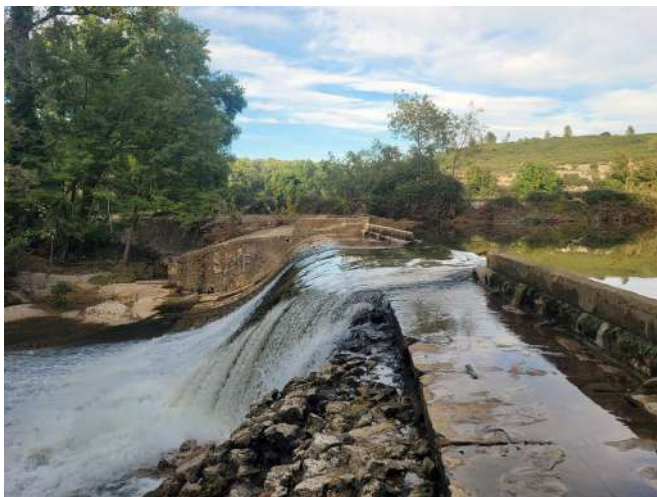
Seuil de Roquefavour © ARBE/L. Guermond
