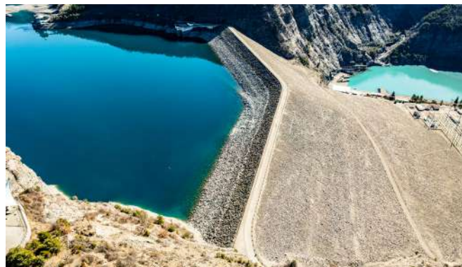
▶ Barrage de Serre-Ponçon
