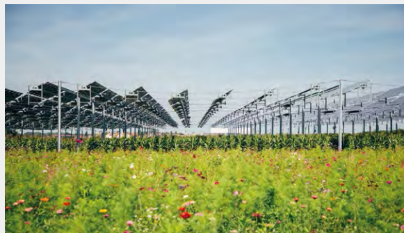
→ Le projet Canopée développé par TSE est un système d'ombrière agrivoltaïque avec panneaux solaires rotatifs.
