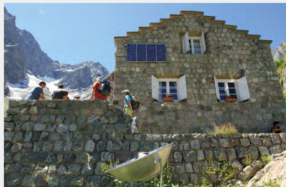
→ Refuge des Bans : panneaux solaires et four solaire.
