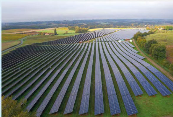
→ Centrale photovoltaïque au sol en Charente. © S. Beillard/OPB
