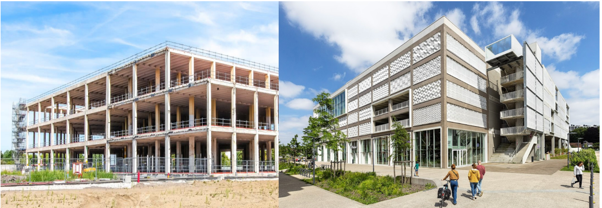
Conservation de la structure en béton d'un bâtiment logistique pour le parking silo – Ecoquartier de la Maillerie - Source Linkcity
