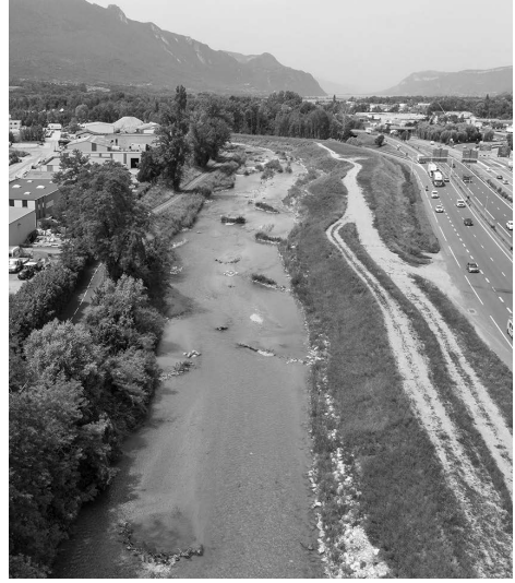
Figure F28.2. La Leysse après travaux, cours d'eau élargi, les digues sont reconstruites (© Photec Production).
