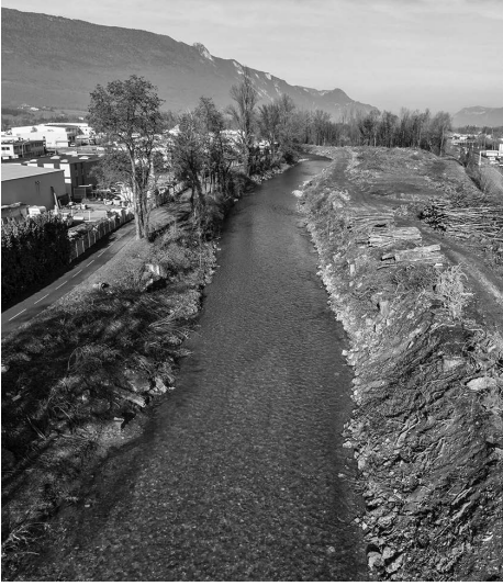
Figure F28.1. La Leysse avant travaux : cours d'eau chenalisé avec des digues en mauvais état (© Photec Production).
