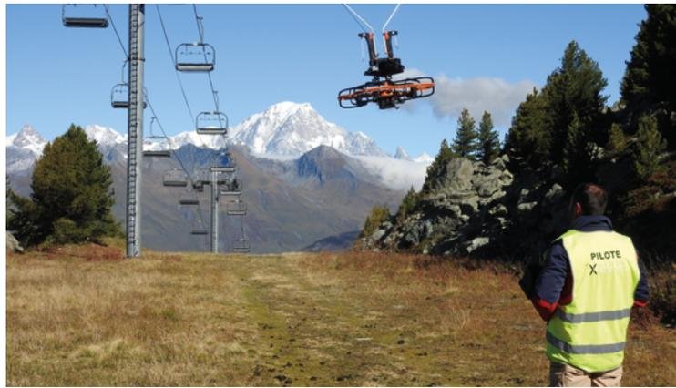
→ Pose d'une birdmark® par drone sur un câble de télésiège.
