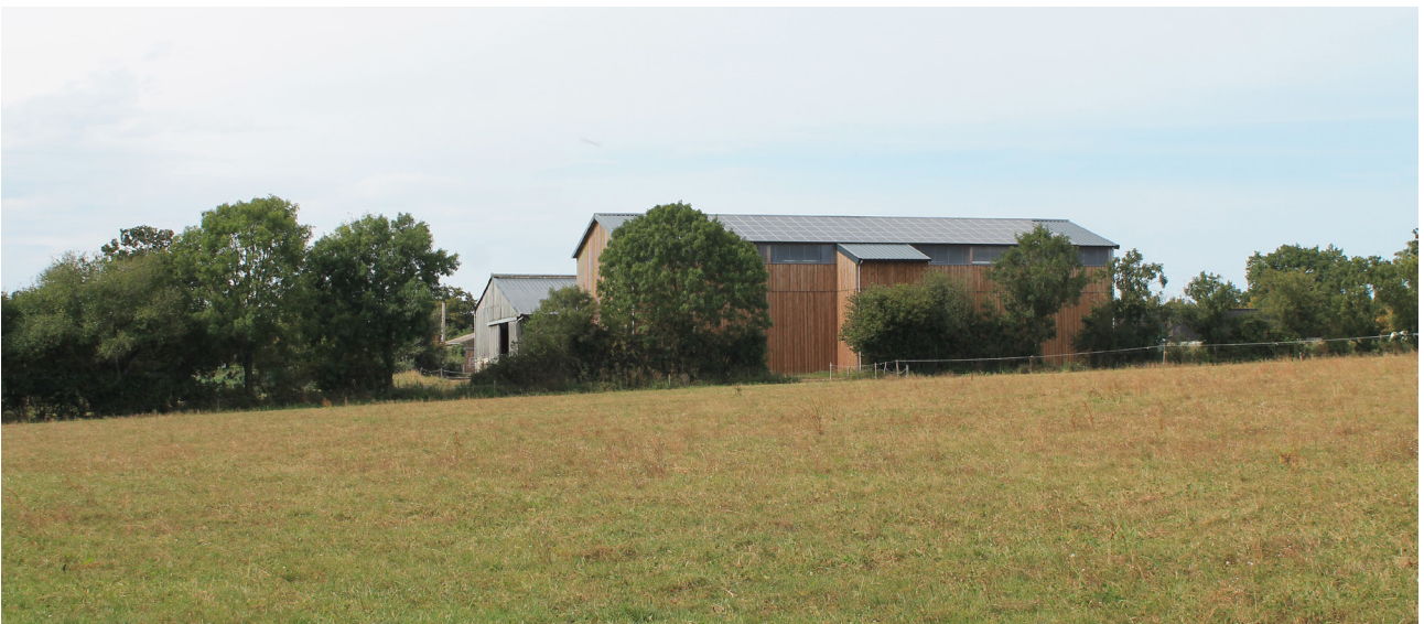
Ferme de la Niro, séchoir à foin thermovoltaïque qui parfait l'équilibre agro-écologique et énergétique de la ferme, Le Boupère, Vendée (c) Gaëlle des Déserts
