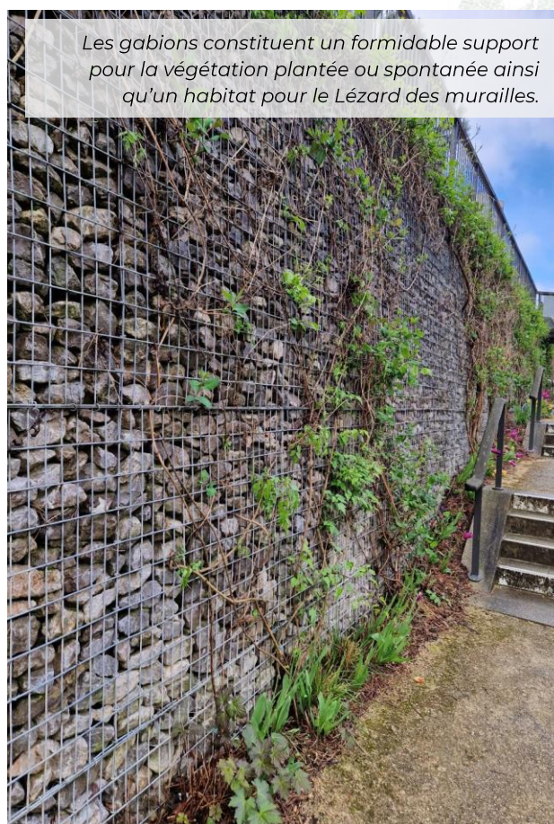
Mur de soutènement en gabion Ecoquartier Charles Trenet (Paris 13 e ) © Capucine Vaissaire / Ville de Paris
