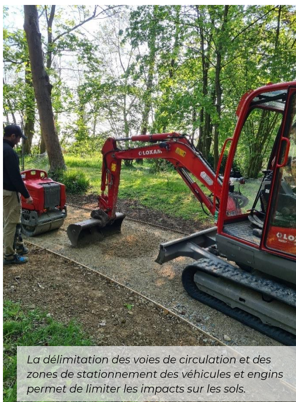
L'utilisation d'engins de catégorie A permet de limiter la compaction des sols.
