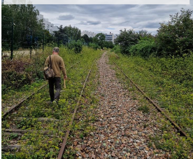
Ballast ferroviaire Petite ceinture ferroviaire (Paris 20 e ) © Capucine Vaissaire / Ville de Paris
