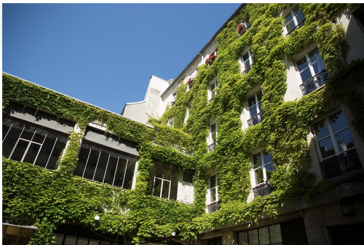
Façade d'une copropriété végétalisée (Paris 4 e ) © Joséphine Brueder / Ville de Paris
