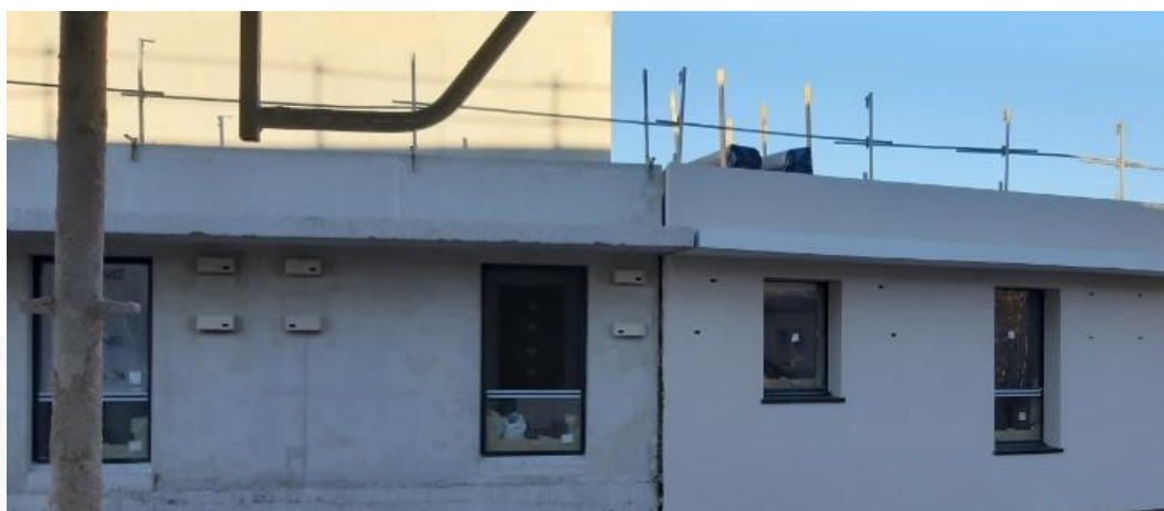
Intégration de nichoirs dans le bâti lors d'un chantier à Toulon © Katherine Dubourg / LPO PACA
