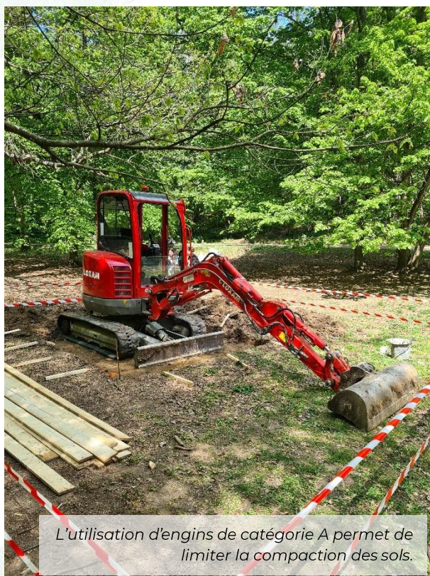
La délimitation des voies de circulation et des zones de stationnement des véhicules et engins permet de limiter les impacts sur les sols.
