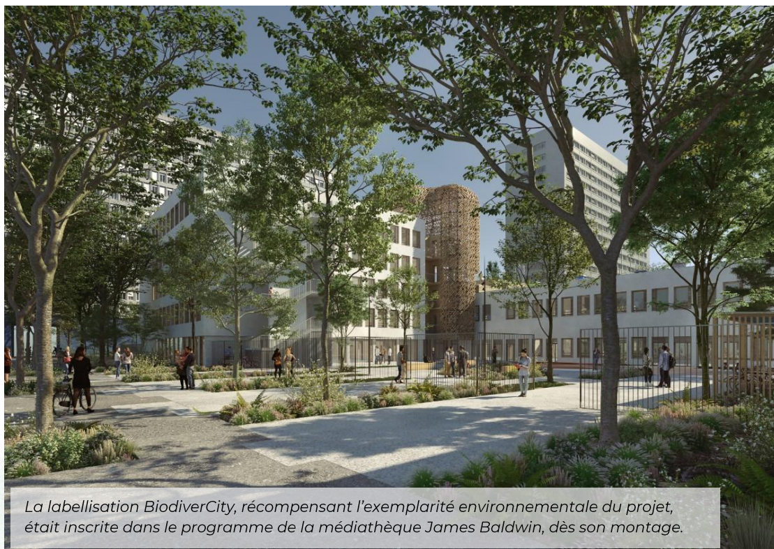
Projet de la médiathèque James Baldwin (Paris 19 e ) © Atelier Madec
