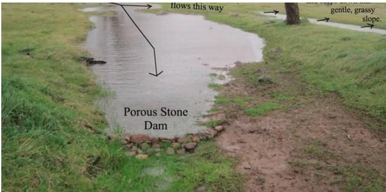
*Mon barrage poreux en pierre préféré parce qu'il n'a que quelques centimètres de hauteur et qu'il détourne les eaux de ruissellement vers un chemin plus lent sur plus de 45m avant qu'elles ne rejoignent le reste des eaux de ruissellement.*
