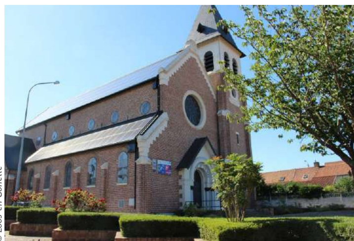
© Loos-en-Gohelle A Loos-en-Gohelle, des panneaux solaires sont installés sur une église
