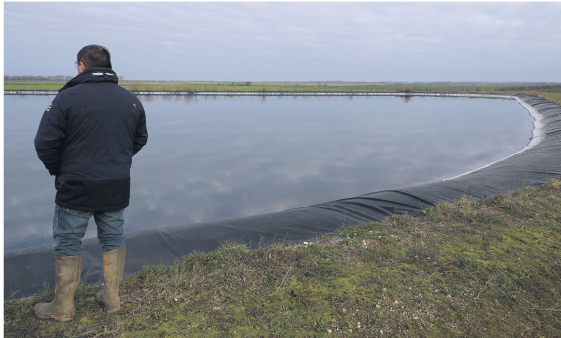
Le sol est creusé sur plusieurs hectares et les déblais servent de digue à la bassine. (Photo NR, X.B.)
