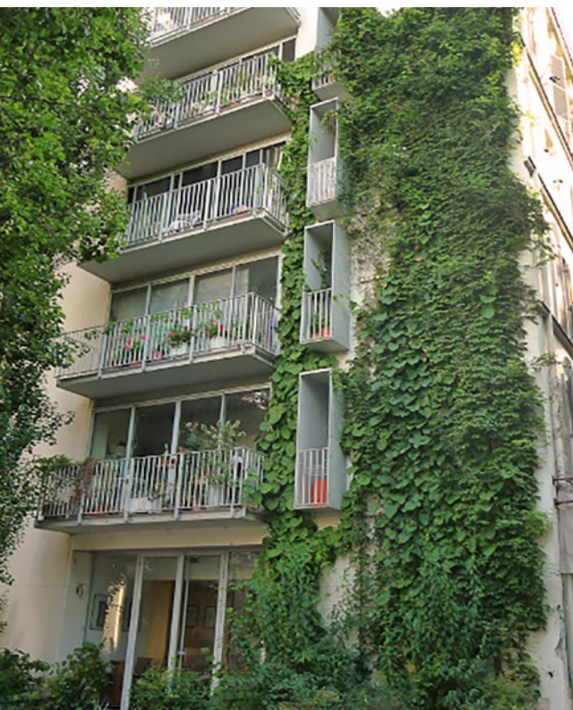
Mur végétalisé, Villeurbanne (69)
