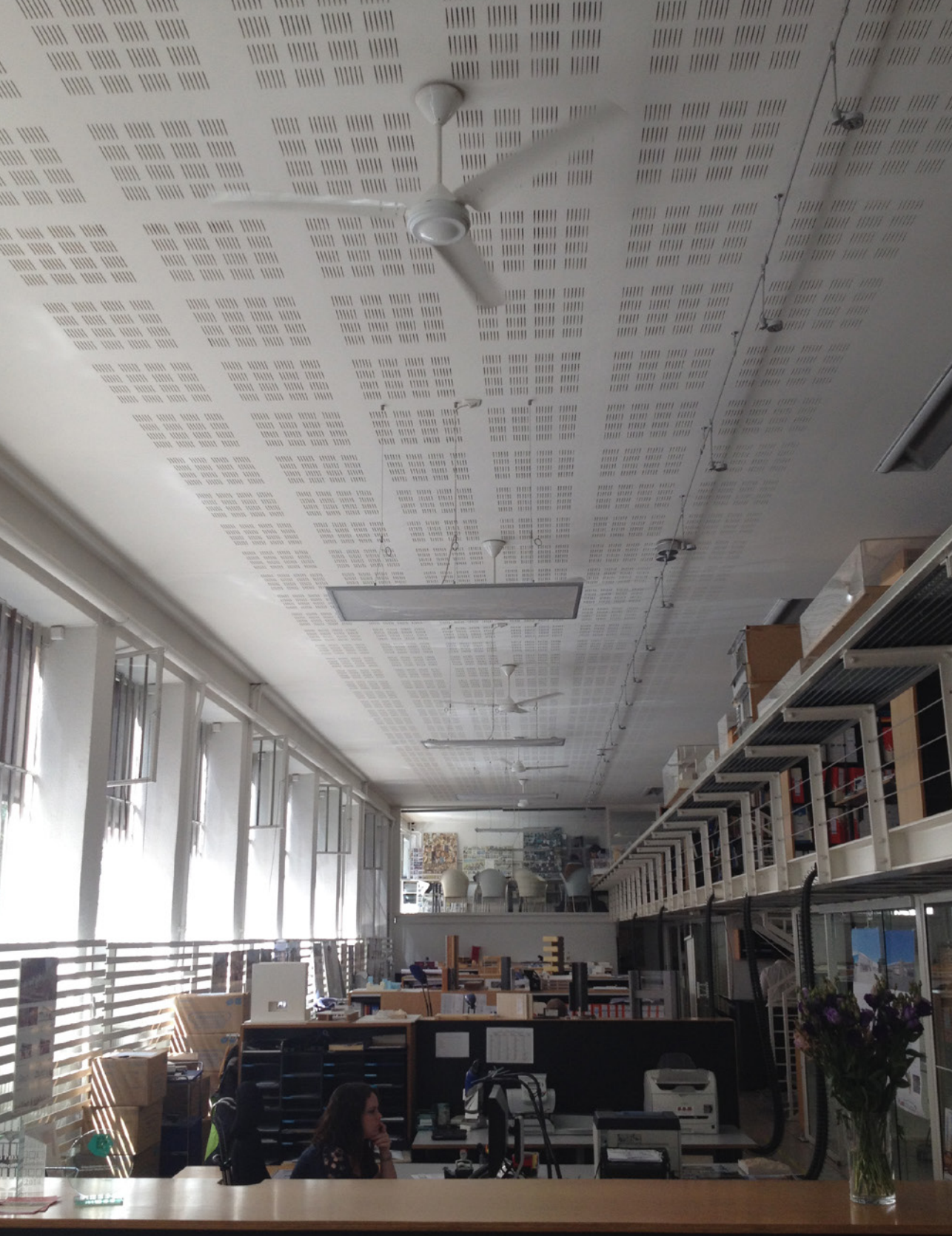
Bureaux sans climatisation, Gautier Conquet Architectes
