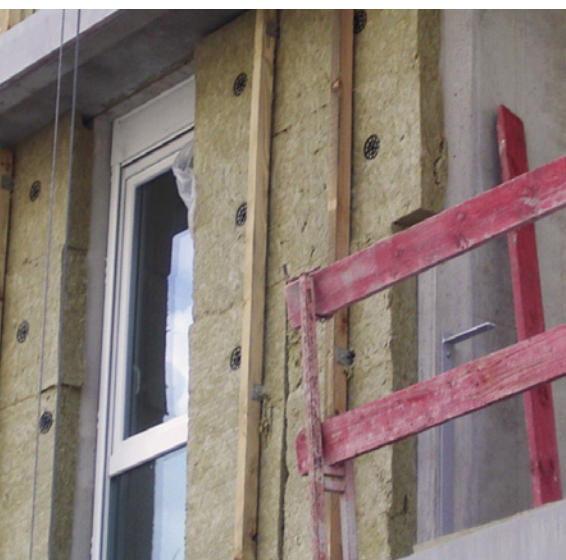
Mise en place d'une isolation de murs par l'extérieur
