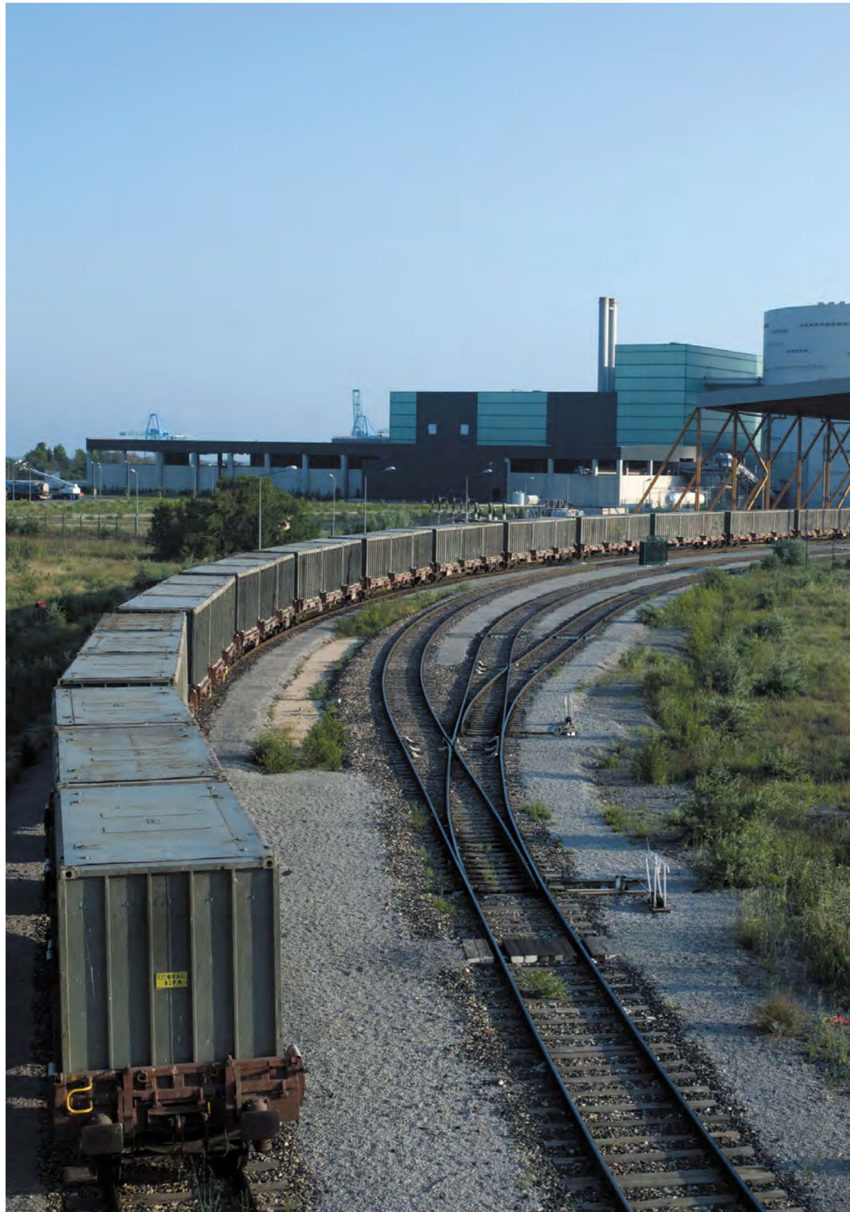
Le centre de traitement multifilières (source : EveRe).
