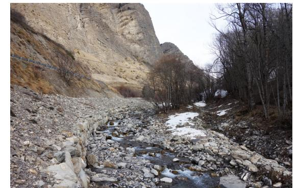
Mur de soutènement avec la pose en enterrée de la canalisation entre le torrent et la route départementale
