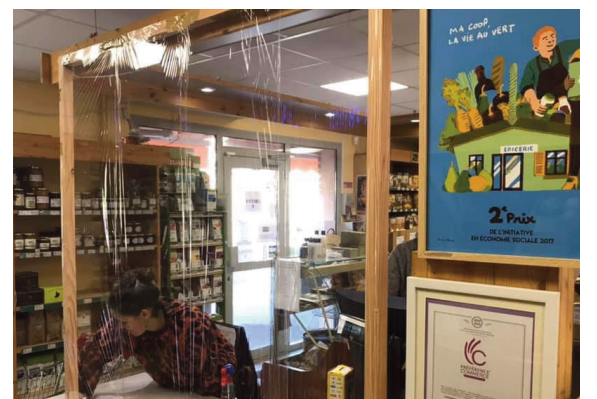
Fabrication d'une séparation à la caisse
